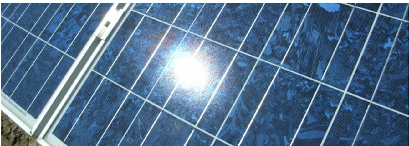
Bild 3.2.2: Diffuse Reflexion von direkten Sonnenlicht (Einstrahlung ca. 980 W/m<sup>2</sup>) auf einem PV Modul (Quelle: SolPEG)
